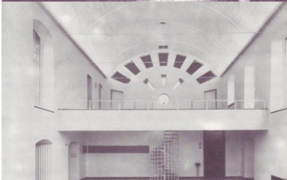
Nach der Renovierung 1959
