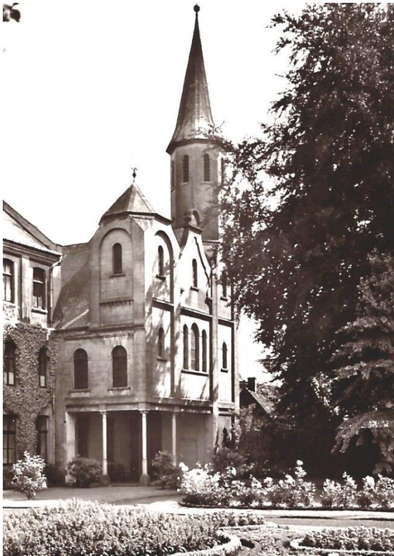
Nach Westen ausgebaute Empore mit Turm und Freisitz um 1905
